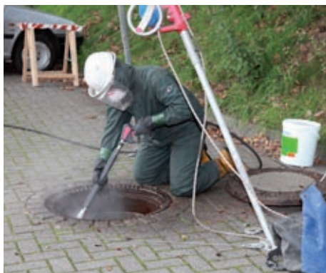
Przygotowanie podłoża (w tym przypadku mycie wodą pod wysokim ciśnieniem)
