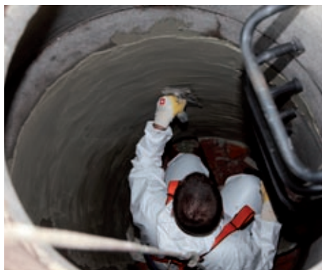
Zaprawa jest nakładana na zwilżone podłoże za pomocą pacy metalowej
