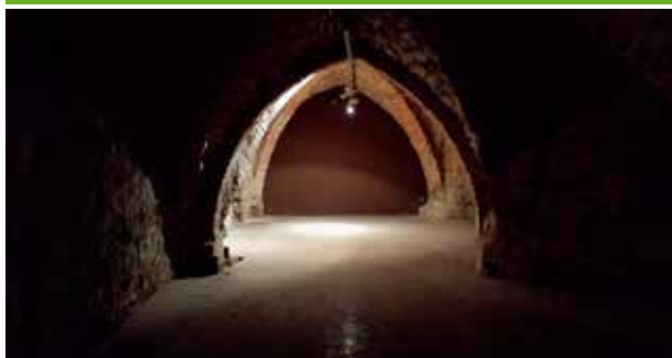
Zabytkowe sklepienie piwnicy
