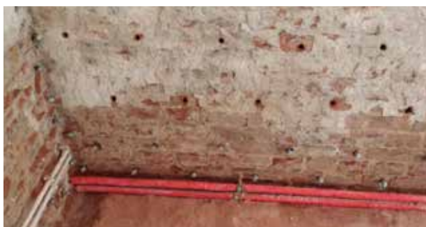
Ściana zewnętrzna z cegły pełnej
