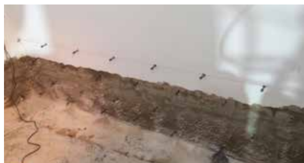
Ściana zewnętrzna z cegły wapienno-piaskowej
