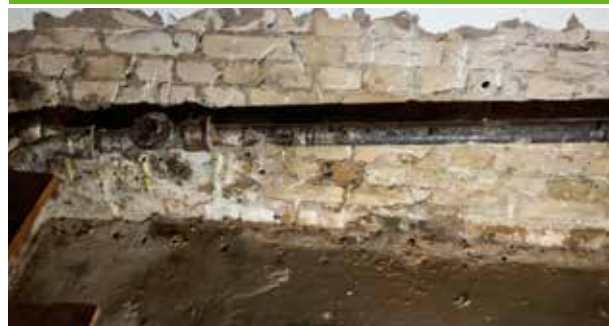
Styk ściany z płytą fundamentową
