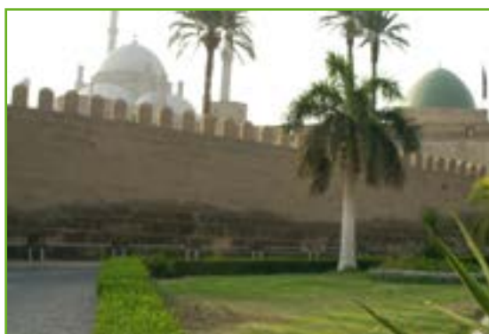
Przykład wilgoci podciąganej kapilarnie
