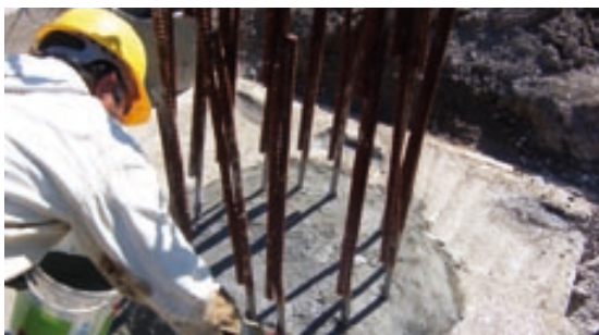
Głowicę pala uszczelnić mikrozaprawą KÖSTER NB 1 szarą.
