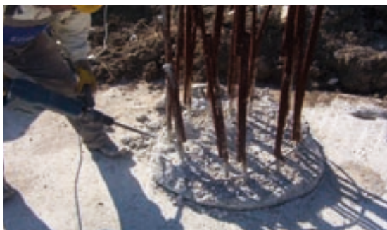
Wystające części usunąć, oczyścić głowicę pala.
