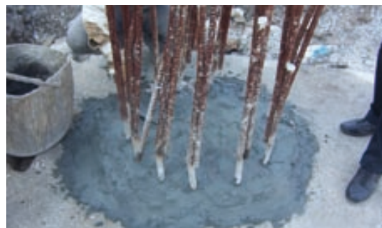
Na styku z głowicą wykonać fasetę oraz wyrównać powierzchnię baretę zaprawą KÖSTER Sperrmortel.
