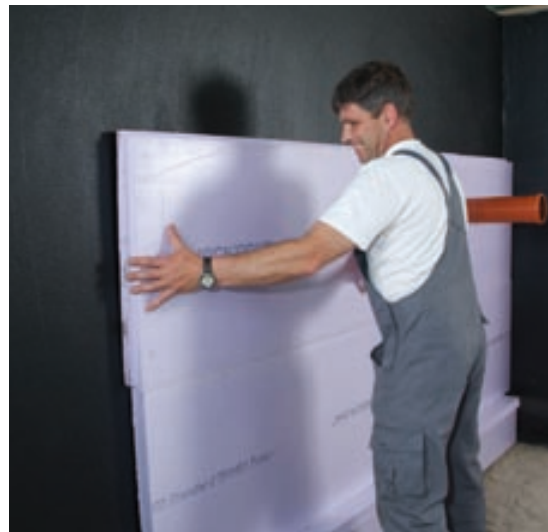
Płyty XPS można kleić do hydroizolacji za pomocą masy bitumicznej KÖSTER Deuxan (Bikuthan).
