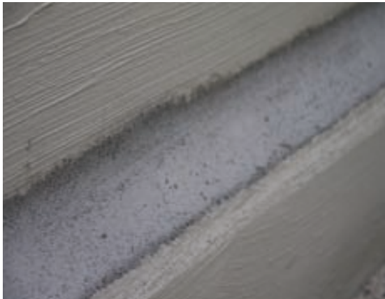
Faseta z zaprawy KÖSTER Sperrmortel na styku ściany z posadzką.
