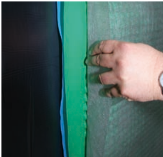
Folia trójwarstwowa KÖSTER SD zabezpiecza hydroizolację i pełni rolę warstwy drenującej.
