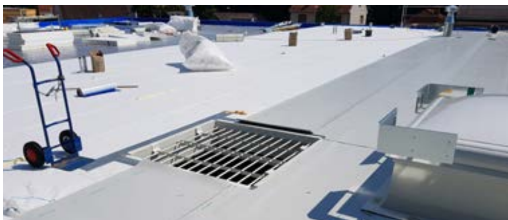
Pokrycie ok. 2300 m 2 dachu pulpitowego z blachy trapezowej jako warstwy nośnej, samoprzylepną paroizolacją, ociepleniem z EPS i warstwą wierzchnią z samoprzylepnej membrany KÖSTER TPO 2,0 SK (FR). Ok. 200 m 2 pokrycia o analogicznym układzie warstw ułożono na płycie żelbetowej.
