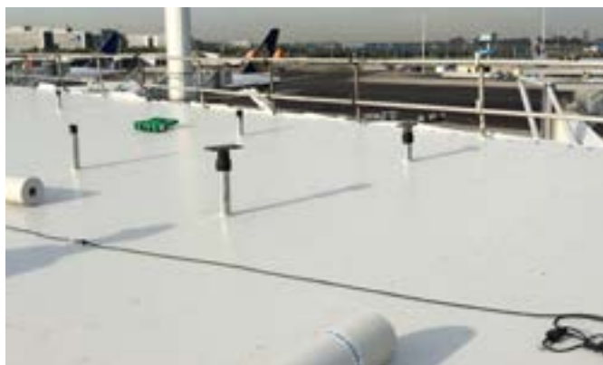
Pokrycie dachu membraną KÖSTER TPO, terminal lotniska Schiphol, Amsterdam
