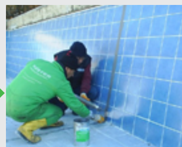
Szczeliny poziome uszczelniono samorozpływną masą uszczelniającą KÖSTER Fugenspachtel FS-H. Tiksotropowa masa KÖSTER Fugenspachtel FS-V została użyta do uszczelnienia szczelin pionowych. Masy KÖSTER Fugenspachtel FS mają wysoką odporność mechaniczną oraz wysoką wartość powrotu poodkształceniowego.
