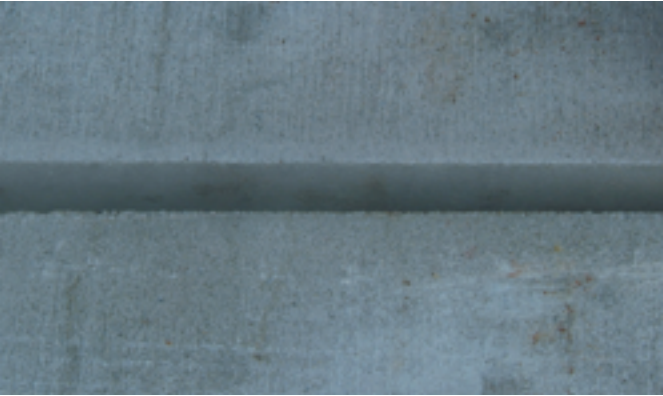
Oczyszczone brzegi i krawędzie szczeliny
