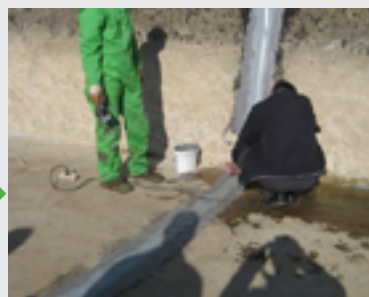
Odcinki taśmy zgrzewa się gorącym powietrzem z zakładem min. 2 cm.
