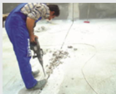
Najpierw usunięto pozostałości i zanieczyszczenia po betonowaniu.
