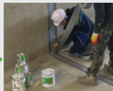
Aby taśma miała możliwość przeniesienia większych przemieszczeń KÖSTER Fugenband wciśnięto trochę w szczelinę formując ją w tzw. omegę.
