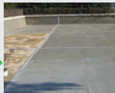
Na tym uszczelnieniu można układać płytki ceramiczne na odpowiednim kleju..
