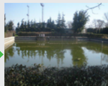
Zastosowane systemy uszczelnień KÖSTER zweryfikowały się pozytywnie w ciągu wielu lat eksploatacji zbiornika Veli Efendi Racetrack i nadal skutecznie go uszczelniają.
