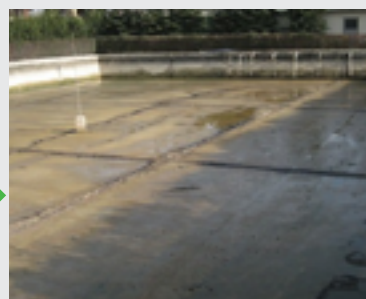
Powierzchnię oczyszczono do nośnego podłoża. Podłoża muszą być czyste, wolne od kurzu, pyłu i innych zanieczyszczeń.
