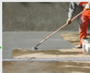
Uszczelnienie powierzchniowe wykonano ze szlamu KÖSTER NB 1 szary uzyskując szczelność przeciw istniejącej wilgoci, wodzie bezciśnieniowej oraz napierającej pod ciśnieniem. Powłoka z KÖSTER NB 1 szary jest odporna na parcie wody od strony pozytywnej oraz negatywnej.
