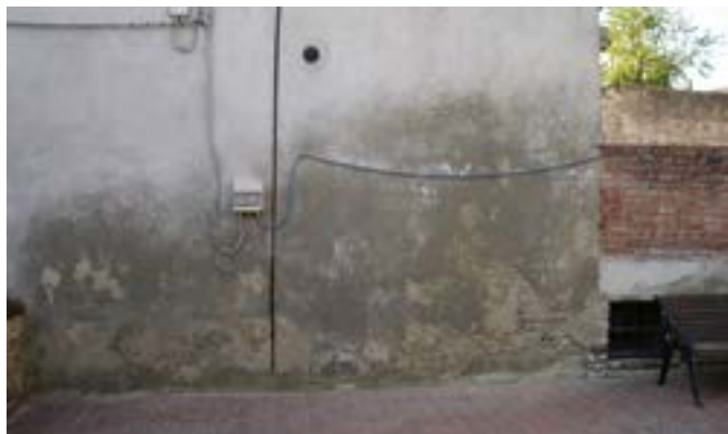
Zmiany koloru powłok malarskich, niekorzystna redukcja parametrów cieplnych
