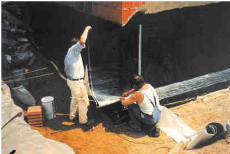
Bild 1: Anarbeiten einer Abdichtung mit KSKDichtungsbahn bei einer Gebäudeecke
