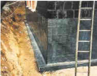
Abb. 4: Fertiggestellte Abdichtung in ausreichender Dicke
