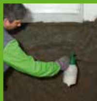
Gruntowanie podłoża KÖSTER Polysil TG 500
