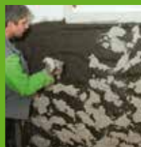
Wykonanie obrzutki renowacyjnej
