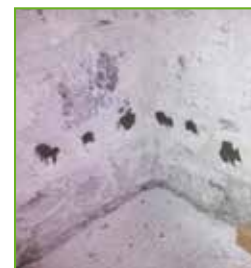
Po wykonanej iniekcji otwory należy zamknąć za pomocą zaprawy KÖSTER KB-Fix 5
