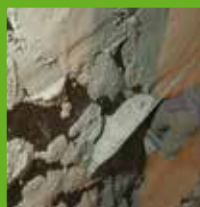
Naniesienie tynku KÖSTER Sanierputz
