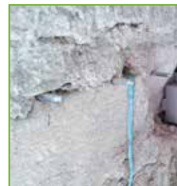
Po rozpoczęciu fazy żelowania, po ok. 45-60 min. można wykonać powtórny iniekcję (iniekcja dwuetapowa)
